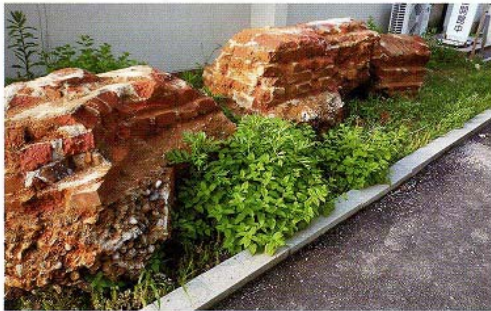
移築された煉瓦基礎
