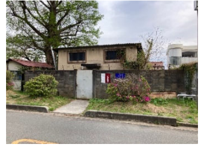
松江地区の危険物貯蔵庫
