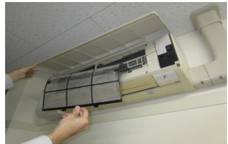
③フィルターを引っ張って取外します。
