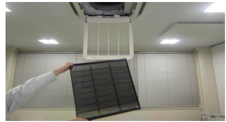
③フィルターを引っ張って取外します。
